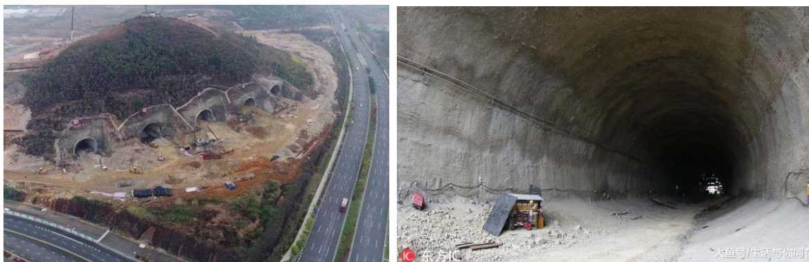
騰訊(テンセント)が貴州・貴安新区に建設中の DC は、山を削り、トンネルをサーバルームに。広さ 3 万平米に 5 万台以上のサーバーを収容する計画。(同社報道、新浪看点 http://k.sina.com.cn/article_6422926890_17ed6162a0010081gv.html )
