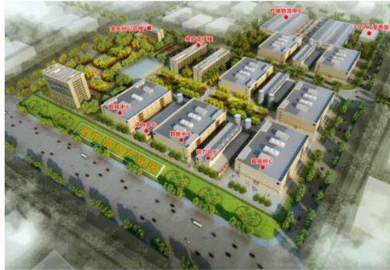
手前には動力設備棟を挟む3つのDC棟がある (同社WEBサイトより)
